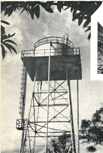
DRUKTANK VOOR DE WATERZUIVERING TE PRABUMULIH.
